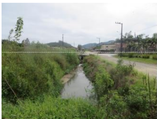
Figura 22. Curso d'água da região do primeiro de maio. Comumente chega a inundar a rua, sem invadir as residências.
