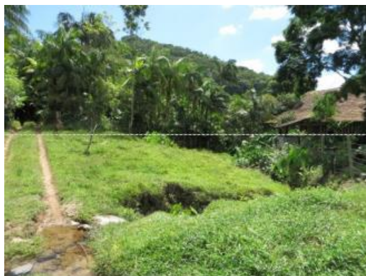
Figura 16. Drenagem muito próxima a construção. Setor SC_MASSARA_SR_6_CPRM.
