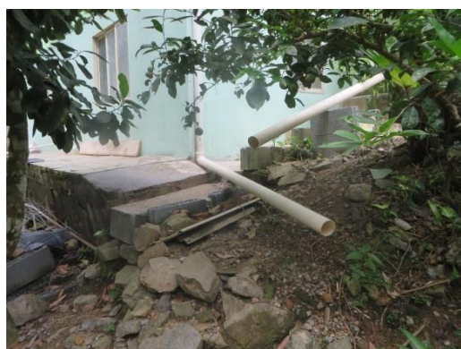
Figura 13. Canos de disposição de água pluvial diretamente na encosta. Setor SC_MASSARA_SR_2_CPRM.
