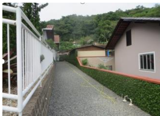
Figura 27. Drenagem canalizada. Quando a chuva supera a capacidade do encanamento a água corre sobre este canal e atinge a rua.
