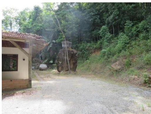
Figura 9. Encosta contendo diversos blocos próximos a moradia. Setor SC_MASSARA_SR_9_CPRM.
