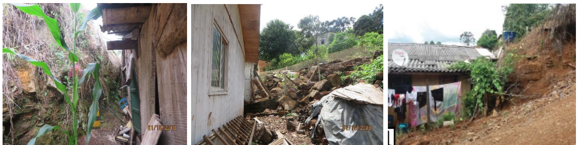
Residências de Brunópolis sob ameaça de deslizamento de terra e blocos
