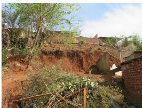
Figura 4: Corte inclinado atrás de moradias.
