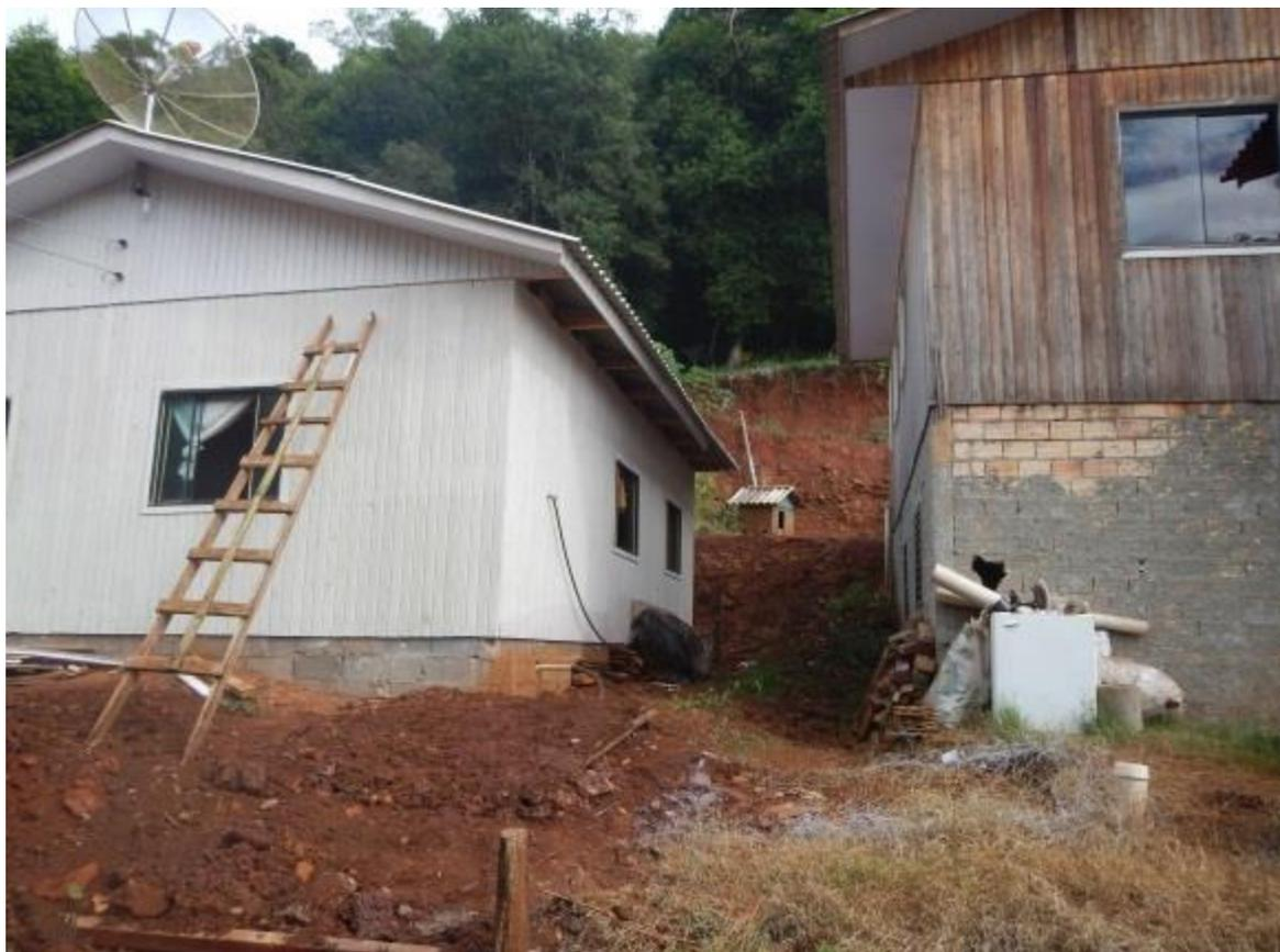
**Figura 7: Casa na área de risco muito alto, construída no sistema de corte e aterro.**
